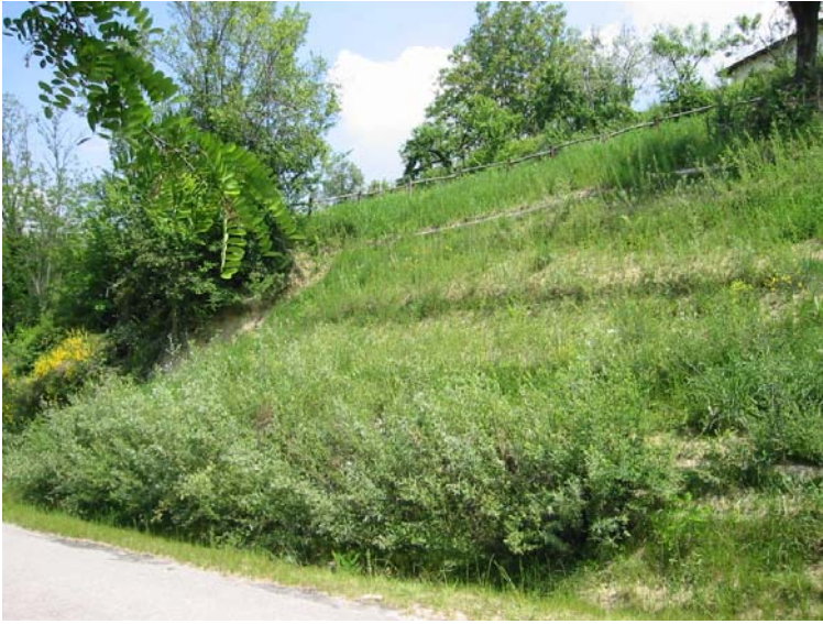
FOYO 4 - Frana su strada provinciale Atina (FR) Sistemazione frana con tecniche di ingegneria naturalistica ( maggio 2002)
