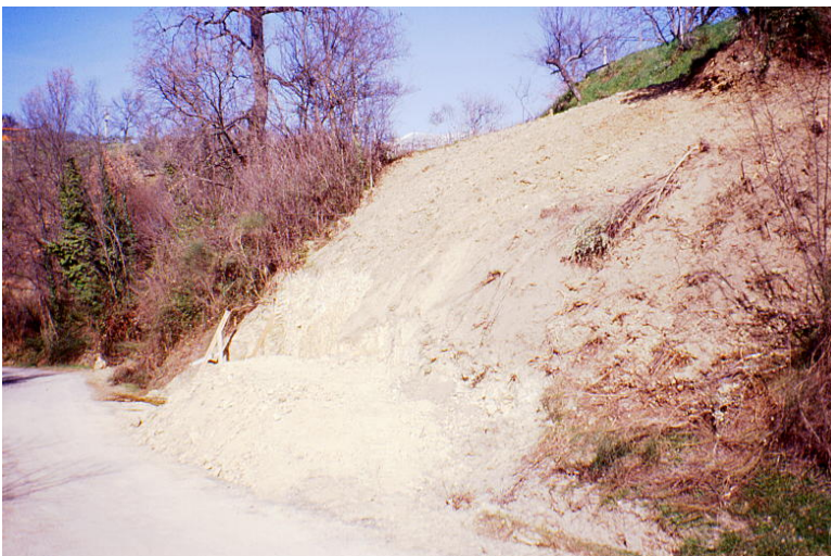
FOTO 3- Frana su strada provinciale Atina (FR) - dicembre 2000
