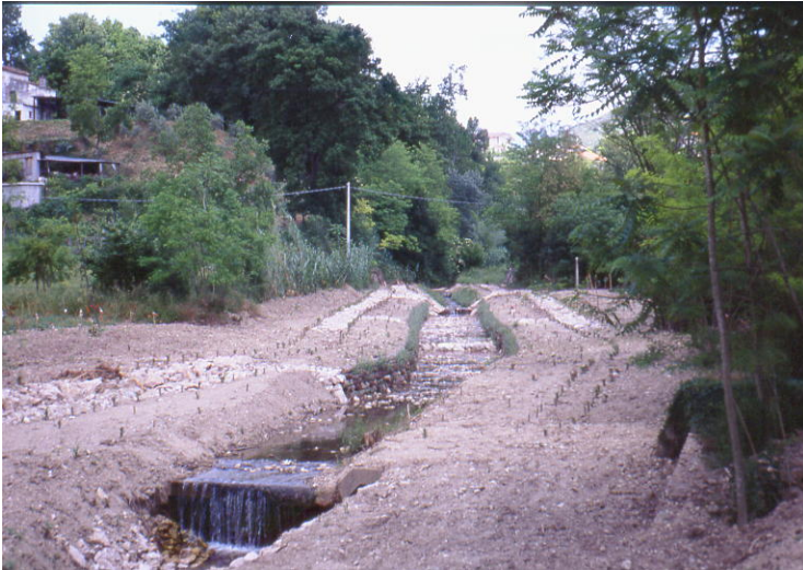
FOTO 1- Interventi sistemazione idraulica con tecniche I.N.tratto superiore Rio Inferno Cassino(FR) ( aprile 2000)
